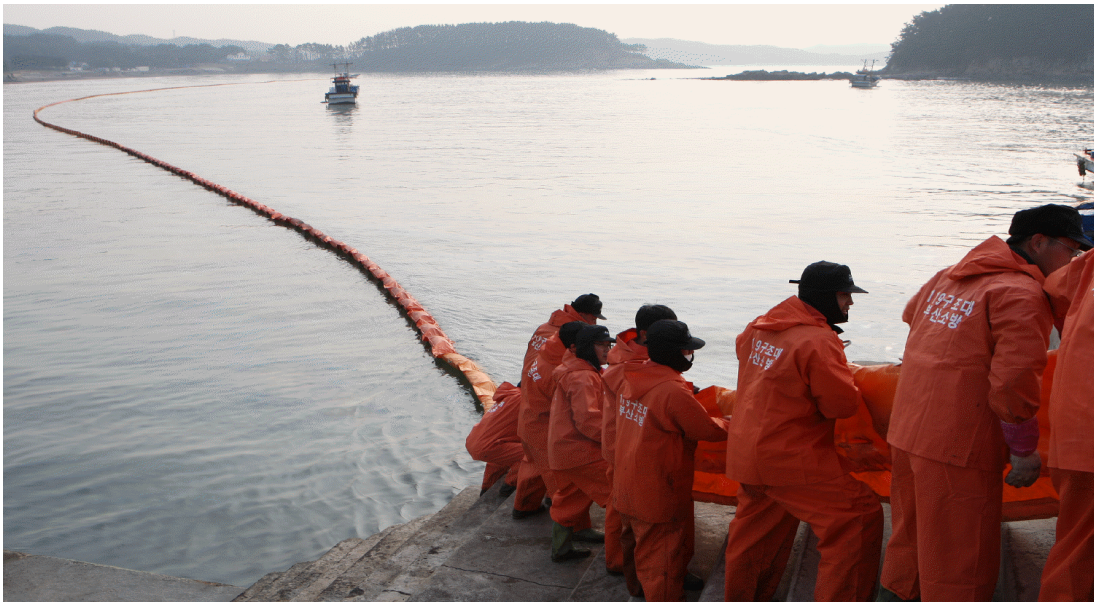
<그림 1-10> 천수만 오일펜스 설치 현장
